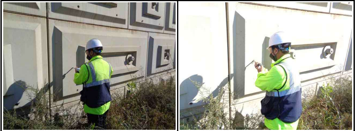
【그림 3.3.6】 슈미트해머를 이용한 반발경도시험 전경
